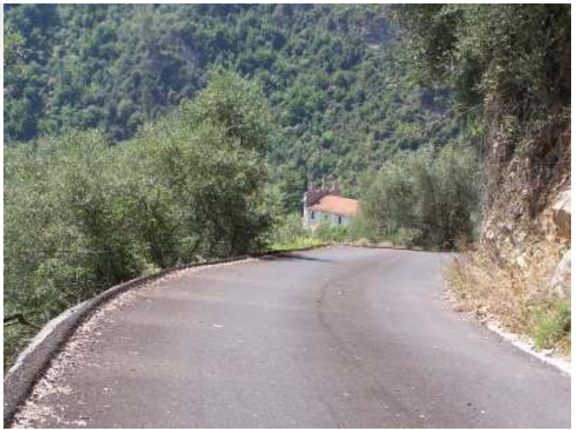
Tratto di strada Fasceo appena asfaltato, località Ciantà
