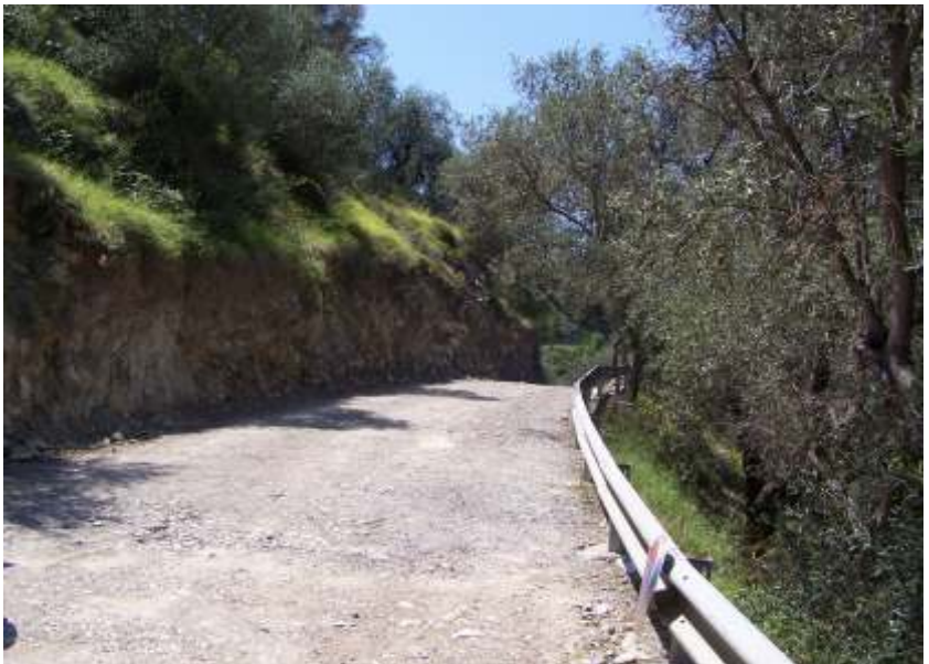
Lavori di allargamento al parcheggio di Via Dante
